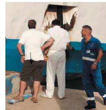
Riparazioni Su un traghetti
